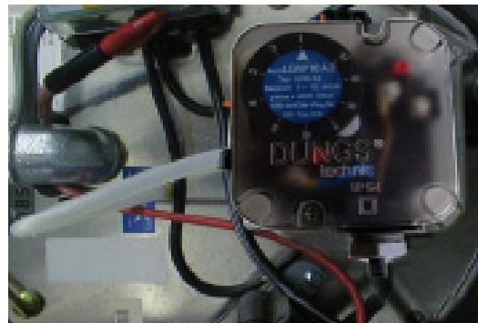
Bei Inbetriebnahme der Gasbrenner Fabrikat Giersch, sind folgende Werte am Luftdruckwächter LGW 10A2 einzustellen
